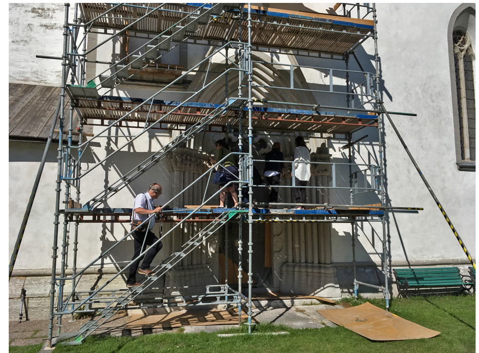
Byggnadsställningarna vid Martebo kyrkas portaler gav symposiedeltagarna ett sällsynt tillfälle att studera kapitälbanden på riktigt nära håll. Foto Annette Landen.
