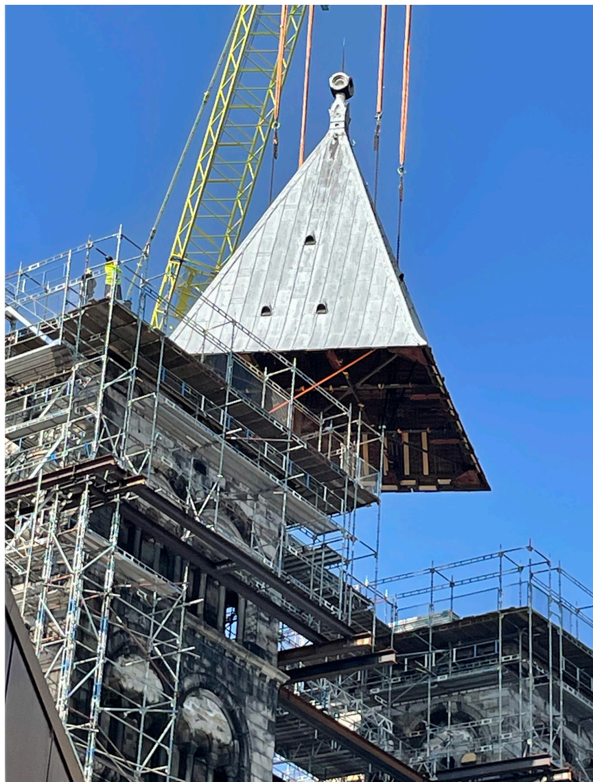
Många samlades kring Lunds domkyrka för att beskåda avtagandet av "hattarna". Här lyfts det södra tornets blyklädda huv, den 23.3.2022. Foto Annette Landen.
